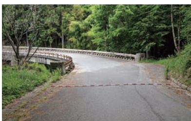
町道128号線 見名一早稲田(堀割) 調査
