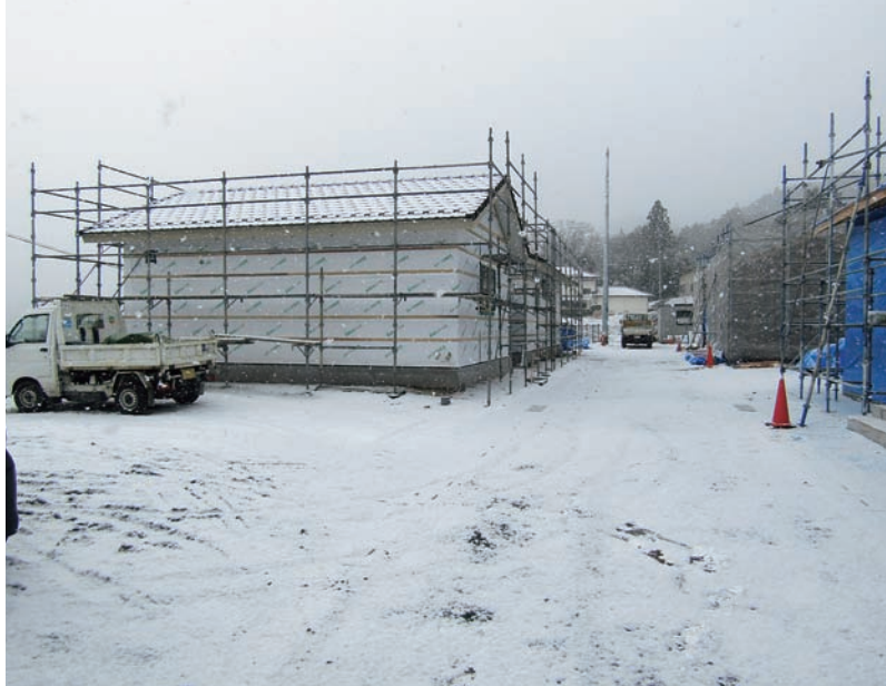
建設中の医師住宅
