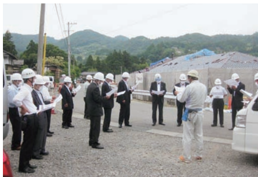
建設中の阿南学園視察
