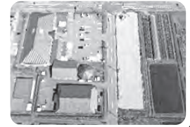
写真：道の駅駐車場整備工事
