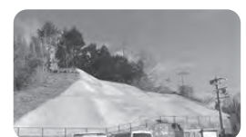
写真：田上(コンビニ裏) 法面防災工事
