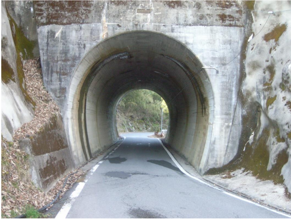
富草中央隧道
