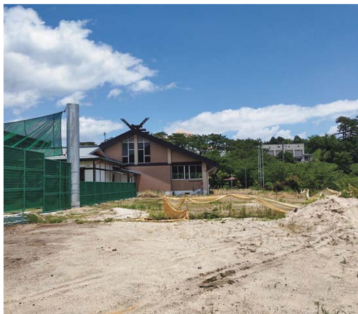
コミュニティの森公園路盤整備変更箇所
