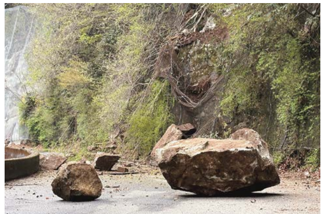
県道深沢阿南線 落石 通行止め
