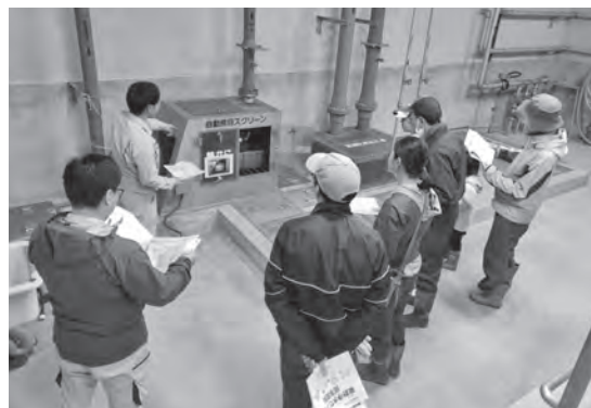
下水処理場の様子
