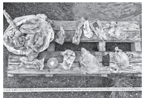
↑マンホール内のごみ
