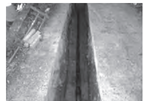
写真：水道管路更新工事
