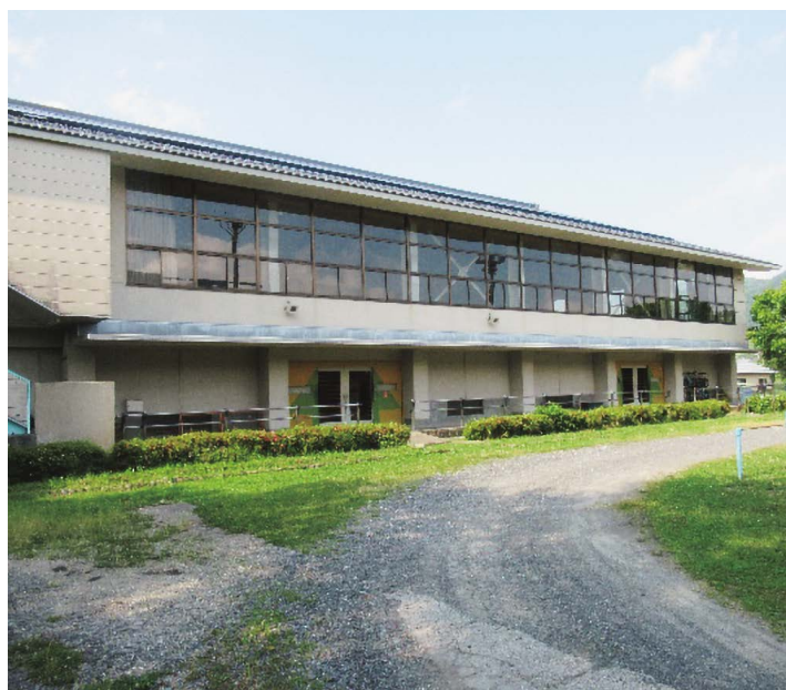
新野小学校体育館
