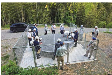
地すべり原因の地下水を集める集水井工視察
