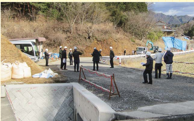
大下条8号線(川田) 道路改良工事
