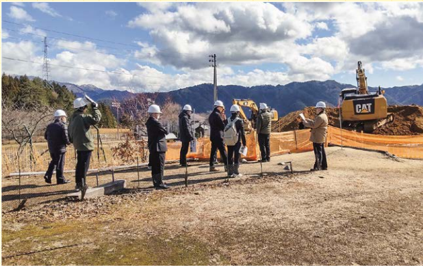
コミュニティの森 敷地造成工事
