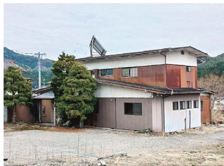
解体予定の旧松澤医院住宅（新野 東町）
