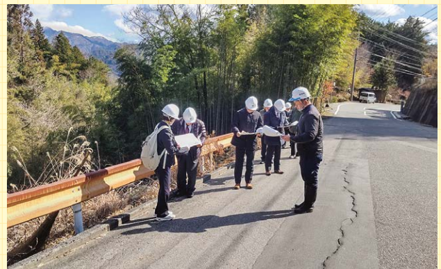
大下条128号線(早稲田) 道路改良工事
