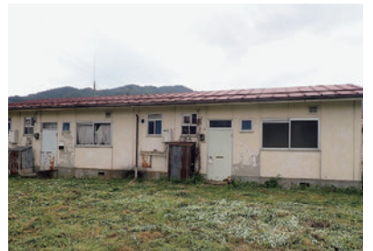
解体される町営新野団地5・6号
