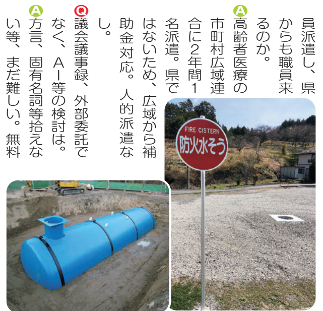
県営中山間事業防火水槽(R5 栗野)
