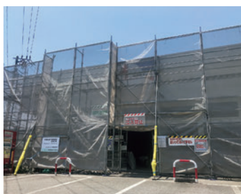
御供区に再建中のスーパー
