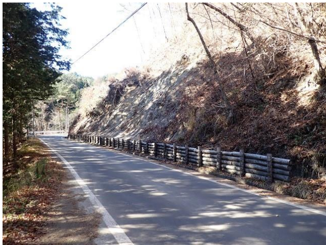
・ 林道大久那線 1工区施工前
