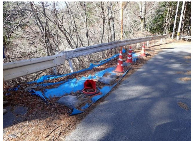
・ 2工区施工前
